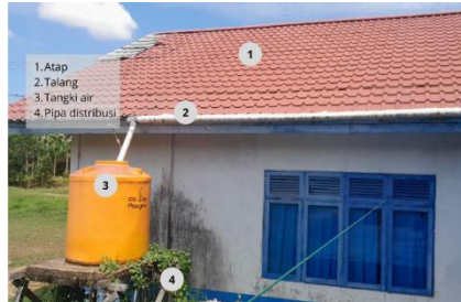
Gambar 2 Komponen Instalasi Pemanen Air Hujan Desa Rasau Jaya Tiga
